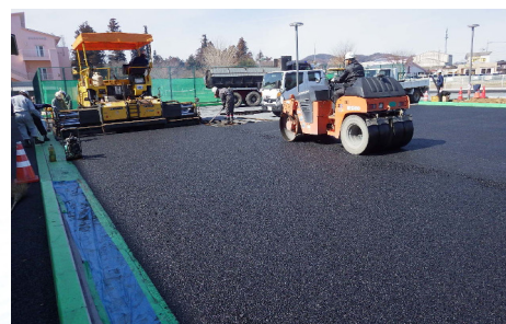
舗装工事状況
