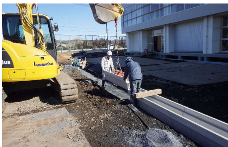
U字溝布設状況
