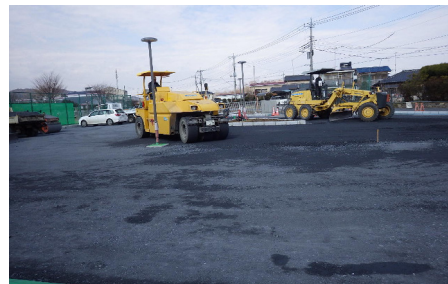
路盤工事状況
